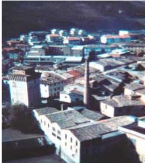
Veduta aerea della centrale in primo piano
