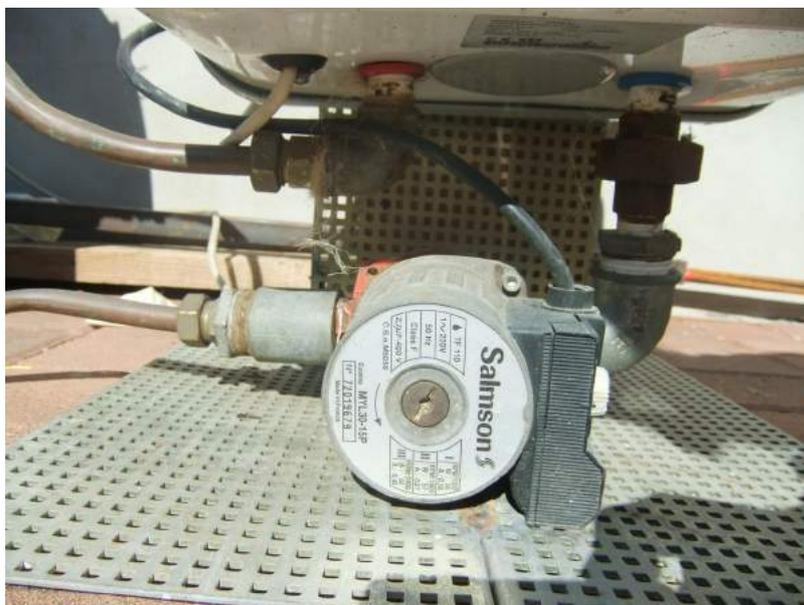
*La pompa di ricircolo, ricavata da un impianto di riscaldamento a caldaia, utilizzata per lo scambio termico a bagnomaria, del digestore.*
