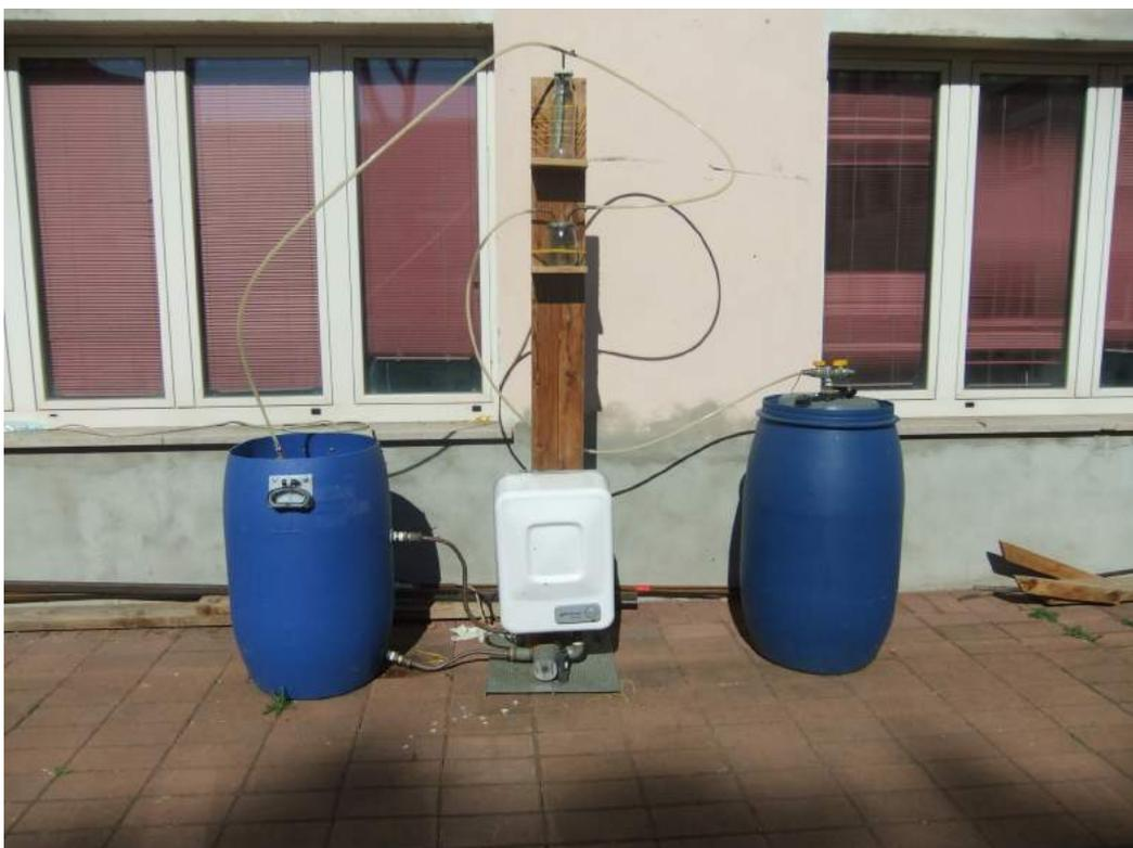
*PRODOTTO FINALE: il boiler arancio, ci faceva saltare la corrente; aveva una perdita di acqua che calava sui contatti del termostato, facendo staccare l'interruttore differenziale del laboratorio; grazie ad un amico un idraulico che ne ha procurato un altro, è stato sostituito da noi, con quello funzionante.*
