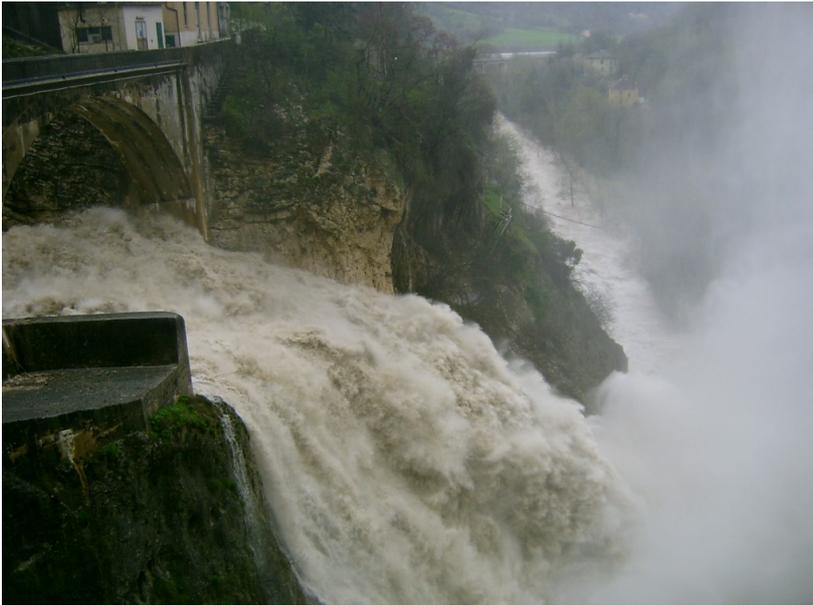
Lo scarico di fondo è profondo 25 m e permette il passaggio dei detriti e della sporcizia. In caso di mancanza di energia elettrica, entra in funzione automaticamente un gruppo elettrogeno, che a sua volta può essere sostituito da una batteria o da una pompa a mano. Quando si è raggiunto il livello massimo, si è a 174.68 m più alti del livello del mare e con un dislivello rispetto alla
