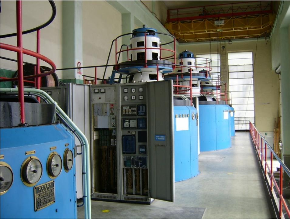
Nella centrale del Furlo sono presenti quattro gruppi di produzione; ogni gruppo è formato da un motore idraulico o turbina, più un alternatore, per una potenza complessiva di circa 13.000 kw.
